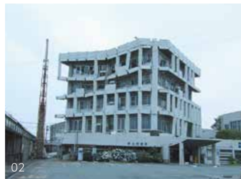
01_被災した建物も多数 02_行政施設も被災
