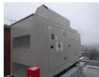
非常用発電機
