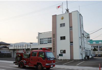
▲建替工事が始まる中央消防署西分署
