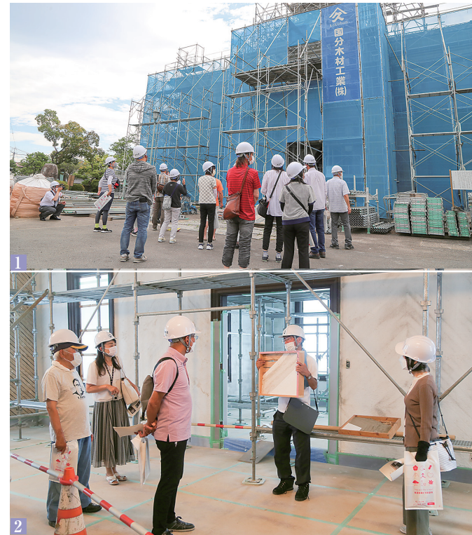
1 工事中の外観を眺めながら、担当者から説明を受ける参加者 2 内観の漆喰壁の塗り直し状況を説明
