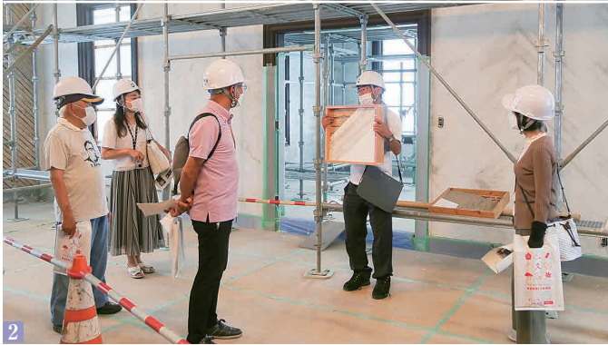
1 工事中の外観を眺めながら、担当者から説明を受ける参加者 2 内観の漆喰壁の塗り直し状況を説明
