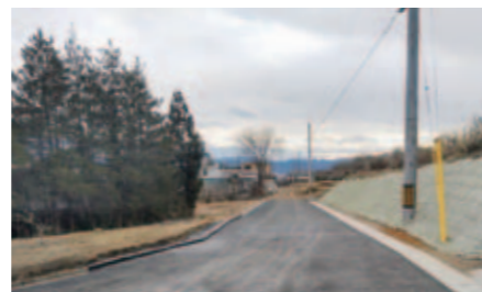
道路改良工事(銀山東線)
