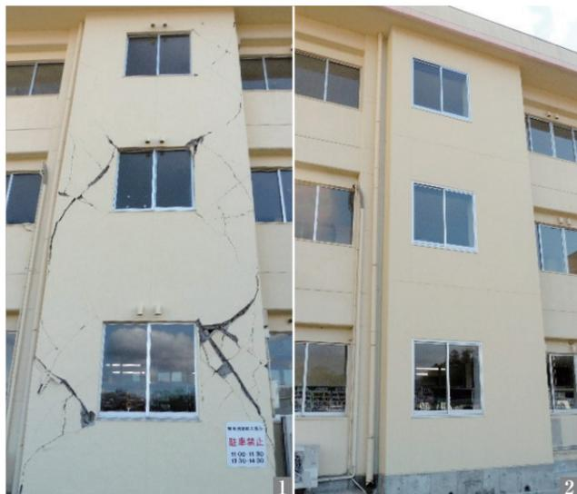
1\_地震発生直後の水飲み場付近の被害の様子 2\_災害復旧工事により、改良・補強された水飲み場付近
