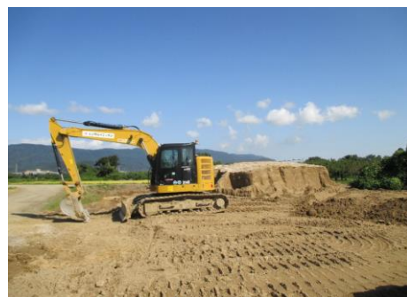
解体作業中の館沢館北仮置場
