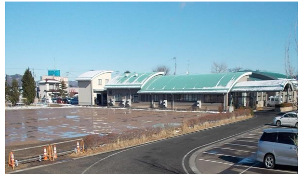
土壌等の搬出作業が完了した追分道下仮置場
