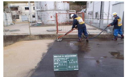
●生活圏の放射線量を低減するための除染作業
