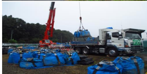
土壌等搬出作業中の根岸熊ノ前仮置場
