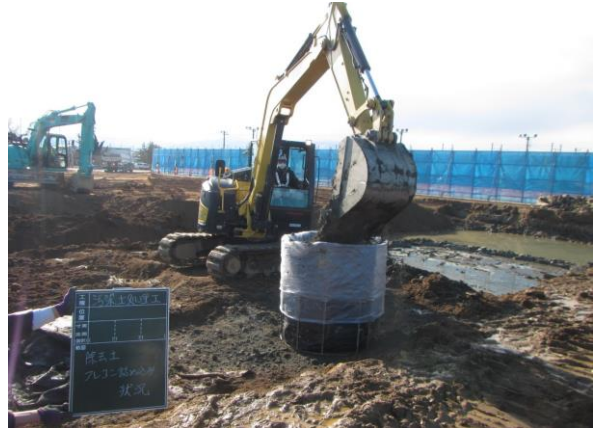
除去物の袋詰めの状況
