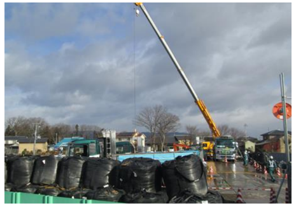
（搬出作業を行っている南郷前田仮置場）
