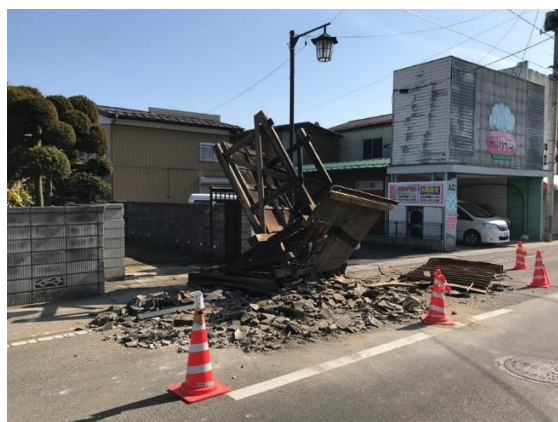
附属建物倒壊状況（北町地区）
