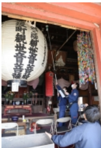
観音寺観音堂自動火災報知設備設置事業
