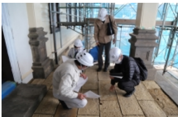
旧伊達郡役所災害復旧保存修理事業
