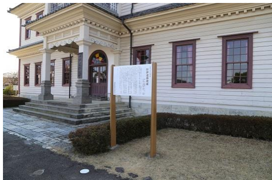
旧伊達郡役所解説板 (修繕後)
