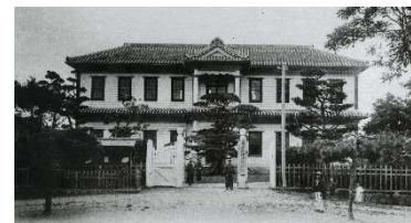
再現する明治の旧伊達郡役所門扉柵
