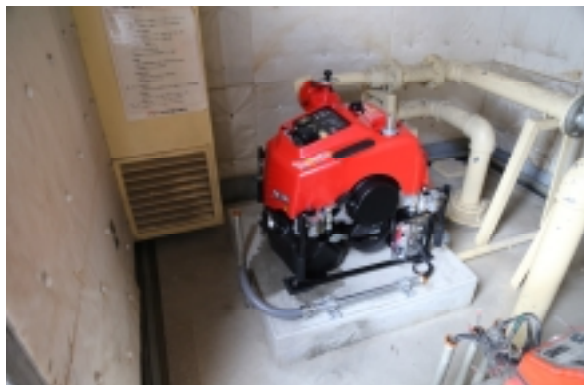
旧伊達郡役所防災設備改修 老朽化した旧伊達郡役所ポンプを更新
