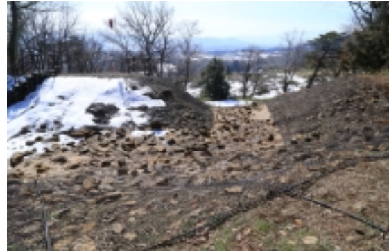
西館枡形状虎口 石積を顕在化し、崩落防止の保護ネットを設置
