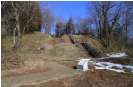
西館枡形状虎口 遺構を整備し、園路、階段、案内板を設置
