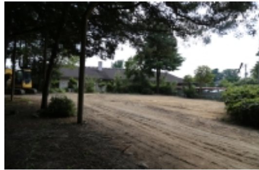
大力ヤ南側にあった住宅を解体撤去
