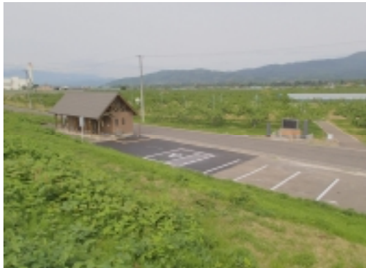
桃の郷トイレ改修事業 桃源郷入口にある桃の郷トイレと周辺の駐車場を改修(阿武隈川堤防上からの景観)
