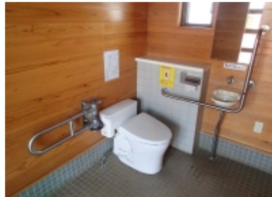
桃の郷トイレ改修事業 多目的トイレを設置し、利便性を図った
