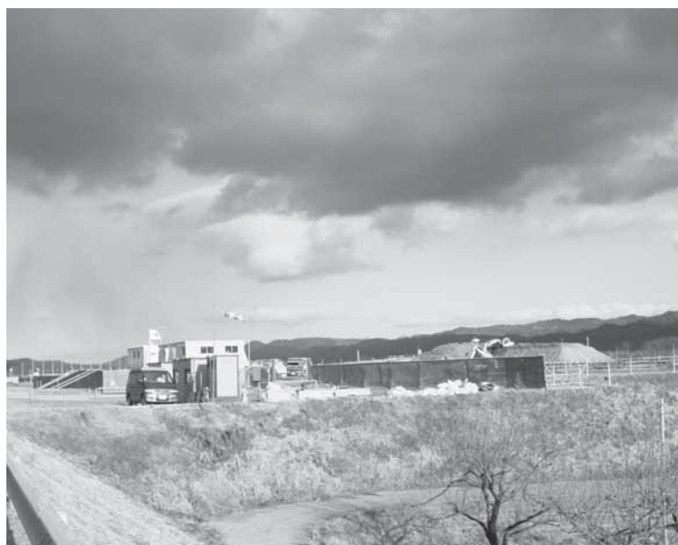
進む汚泥再処理センター
