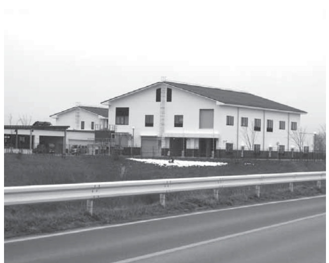
—整備されたし尿処理場—
