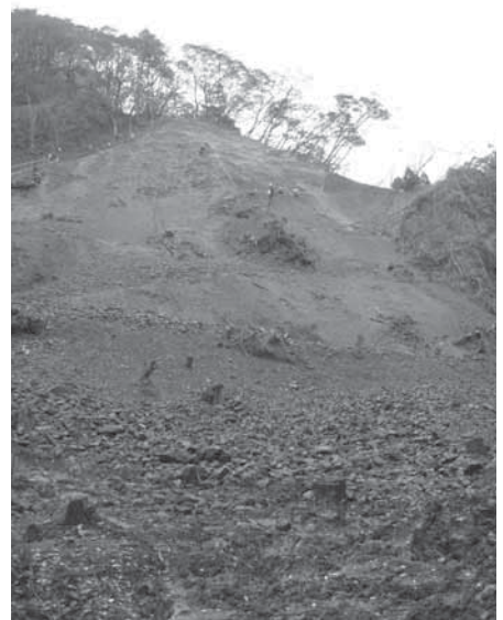
—半田山防災工事—
