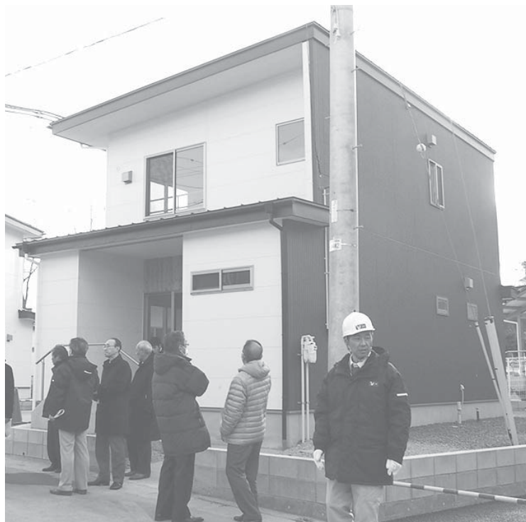
— 完成まじかの災害公営住宅 —
