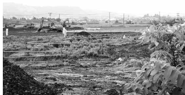
— 4年後の開通をめざし工事が進む —
