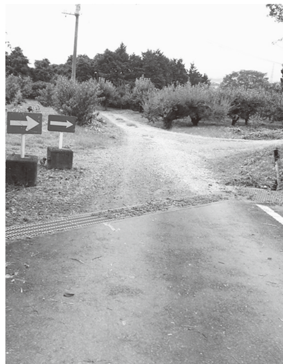
ー工事再開がまたれている志田ノ内線ー
