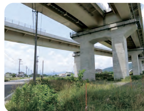
三角地区水道管布設予定現場
