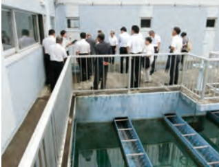
浄水場内施設
