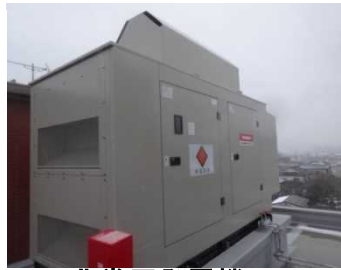
非常用発電機
