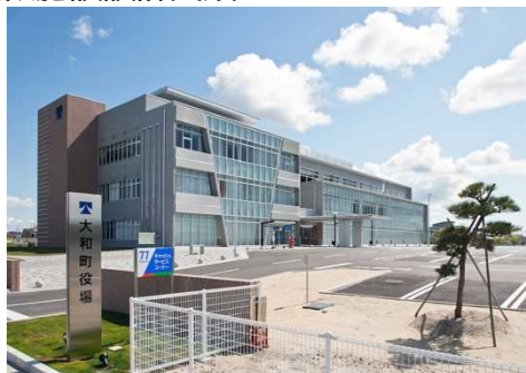
宮城県大和町役場庁舎
