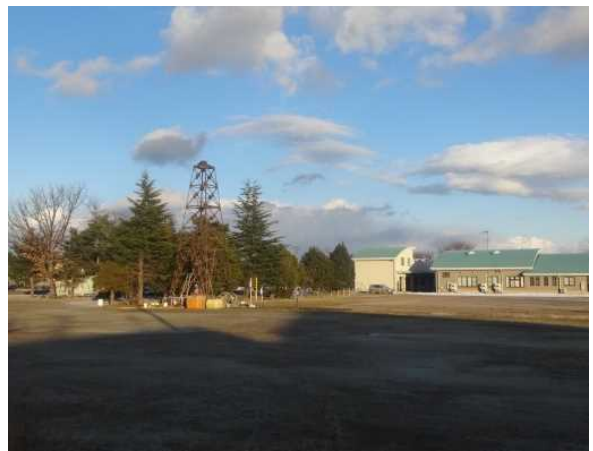
ボーリングの様子(中央左の塔屋)
