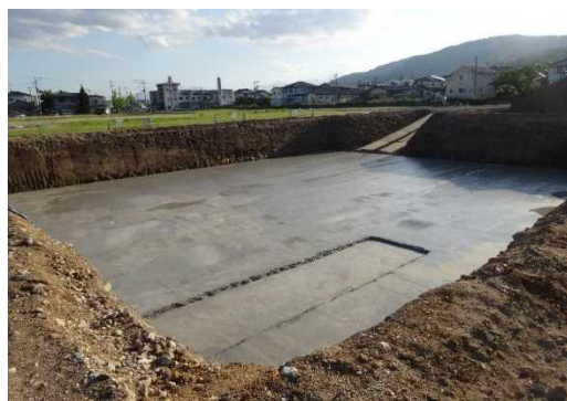
調整池設置箇所の現況(手前の段差は排水部)
