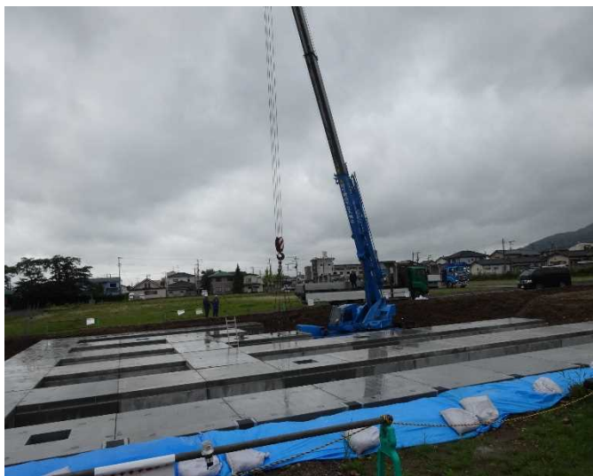
\cap 型構造物の設置
