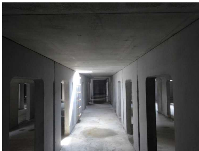
調整池の内部
