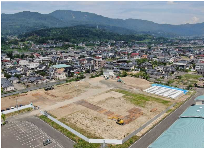
敷地南東側より(8月)
