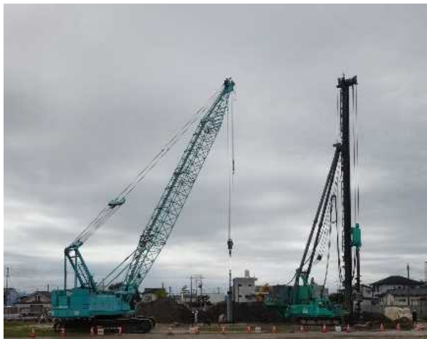
2台の重機による杭工事
