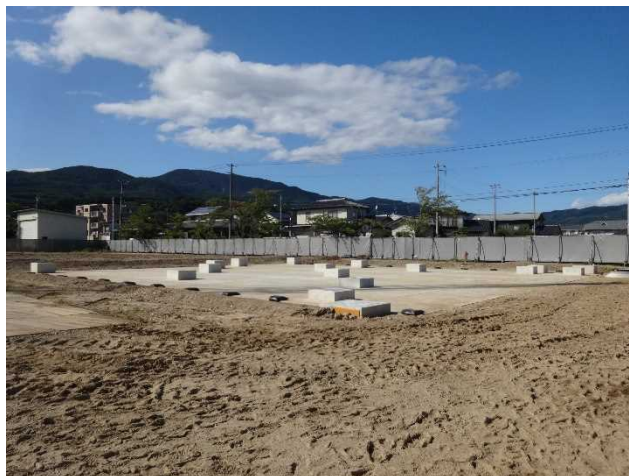
建設地北側(調整池周辺)の仮囲い完了
