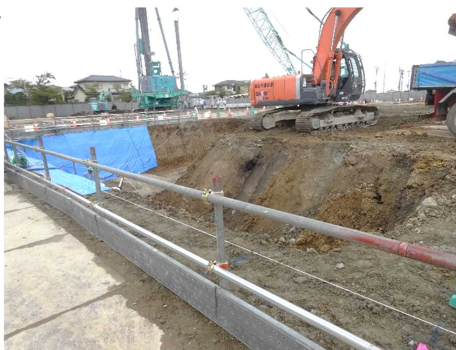
基礎工事における地面の掘削
