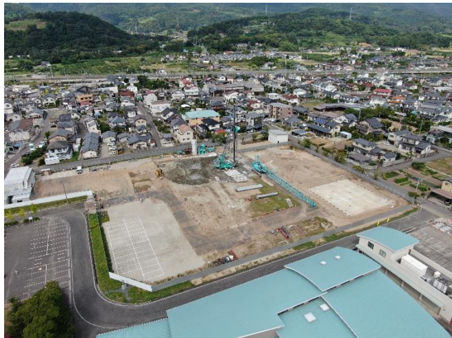
敷地東側より(9月杭工事)
