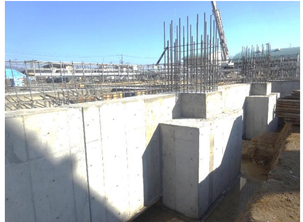
建物を支える地下の構造体(上端が地面の高さ)
