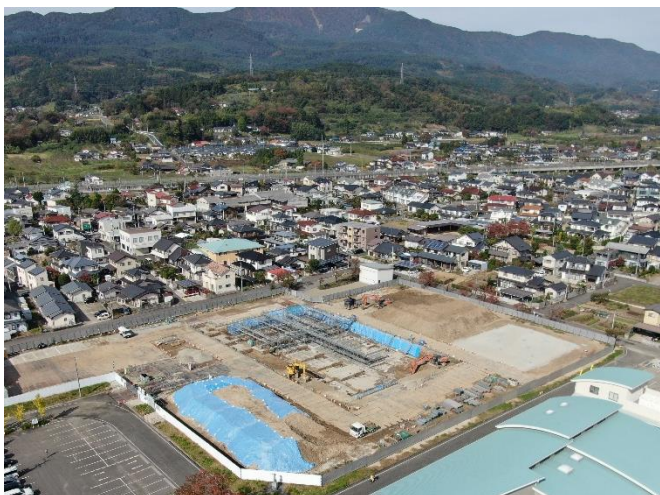
敷地南東側より(11月基礎工事)
