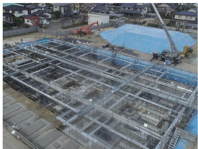
基礎工事の様子(11月)
