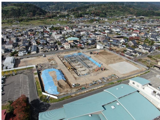
敷地東側より(11月基礎工事)
