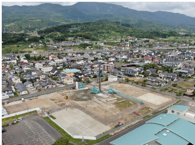
敷地南東側より(9月杭工事)
