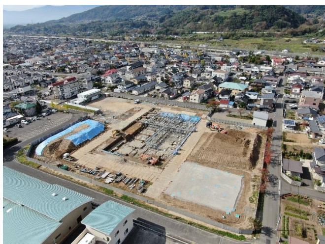
敷地北東側より(11月基礎工事)
