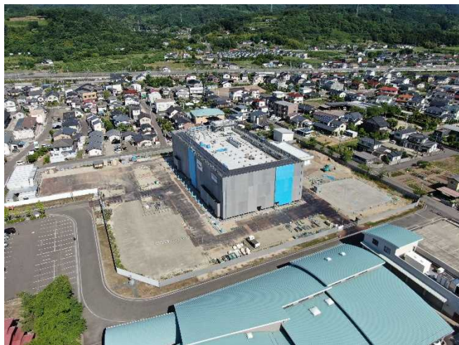
敷地南東側より(6月末内部外部仕上工事)
