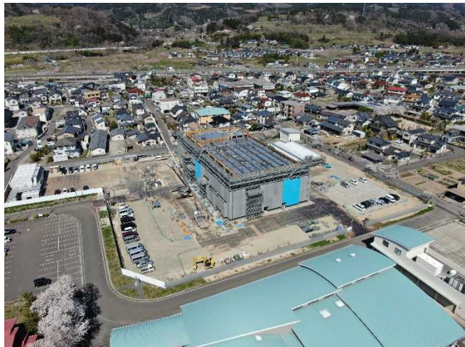
敷地南東側より(4月中旬地上躯体工事)
