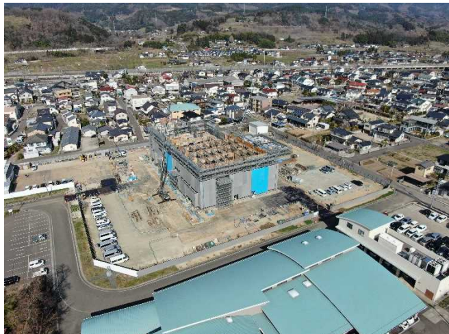
敷地南東側より(3月末地上躯体工事)
