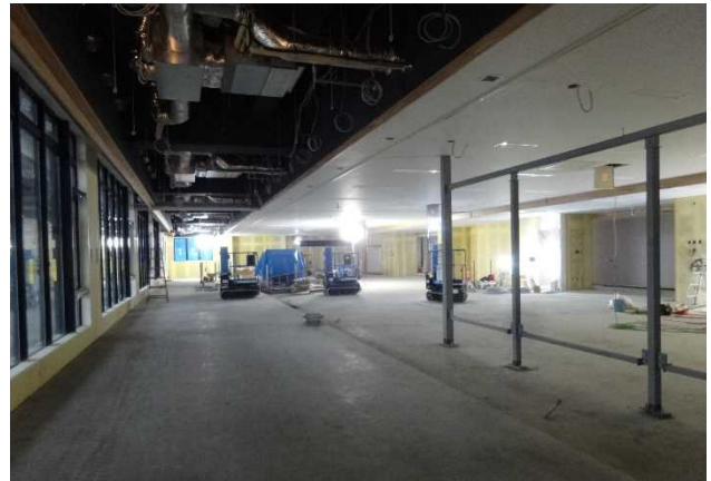
1階窓口付近の現況(窓・天井材取付完了)
