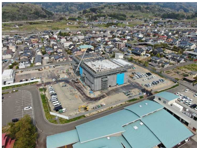
敷地南東側より(4月末地上躯体工事)
