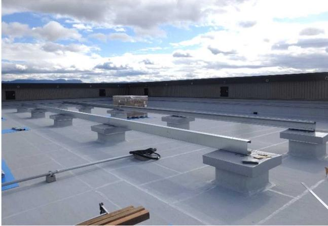
太陽光パネルを乗せる架台の組立(ACDC 施工中)
