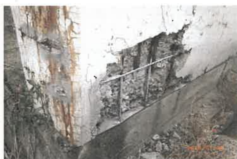
010. 山屋敷橋：PCラーメン橋 (橋長：44.10m、1973年竣工) 橋脚垂直材の鉄筋露出 ※露出鉄筋の断面欠損により、耐荷力の低下が推測される。(迂回路有り)
