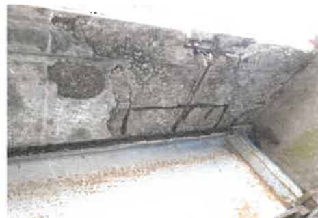
018. 西北沢橋：鋼H桁橋 (橋長：17.580m、1968年竣工) 床版下面の鉄筋露出 ※露出鉄筋の著しい腐食により、耐荷力の低下が推測される。(迂回路有り)
