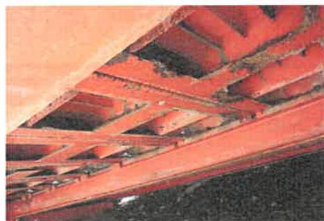
013. 堰向橋：鋼I桁橋 (橋長：32.20m、1978年竣工) 鋼床版の断面欠損 ※断面欠損及び破断により、耐荷力の低下が推測される。(迂回路有り)
