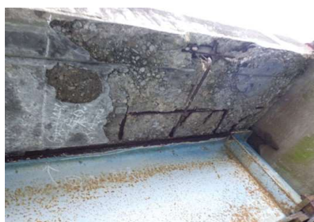
018. 西北沢橋：鋼H桁橋 (橋長：17.580m、1968年竣功) 床版下面の鉄筋露出 ※露出鉄筋の著しい腐食により、耐荷力の低下が推測される。(迂回路有り)
