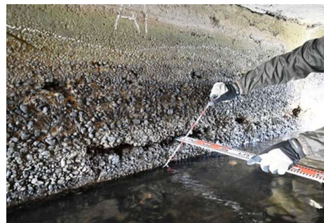
102. 2027-1 : RC中実床版橋 (橋長 : 4.15m、1965年竣工) 下部工の洗堀 ※露出鉄筋の著しい腐食により、耐荷力の低下が推測される。(迂回路有り)
