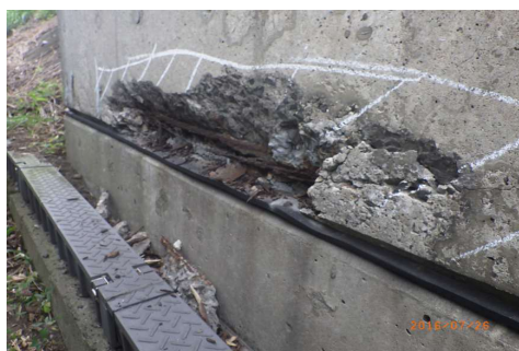
008. 古釈迦堂橋：PCラーメン橋 (橋長：42.25m、1973年竣功) 橋脚垂直材の鉄筋露出 ※露出鉄筋の断面欠損により、耐荷力の低下が推測される。(迂回路有り)
