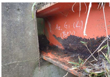
0072. 1086-3：鋼H桁橋 (橋長：12.00m、1978年竣功) 主桁の板厚減少を伴う腐食 ※板厚減少により、耐荷力の低下が推測される。(迂回路有り)
