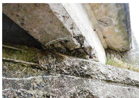
030. 102-1大澤橋：RCT桁橋 (橋長：8.90m、1933年竣功) 主桁下面及び側面の鉄筋露出 ※露出鉄筋の著しい腐食により、耐荷力の低下が推測される。(迂回路有り)
