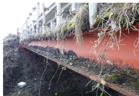
073. 1086-4 : 鋼H桁橋 (橋長 : 12.00m、1978年竣工) 主桁の板厚減少を伴う腐食 ※下フランジの板厚減少は耐荷力の低下が推測される。(迂回路有り)
