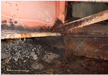
069. 1084-2 : 鋼H桁橋 (橋長 : 14.10m、1978年竣工) 主桁の板厚減少を伴う腐食 ※支点上での板厚減少は耐荷力の低下が推測される。(迂回路有り)
