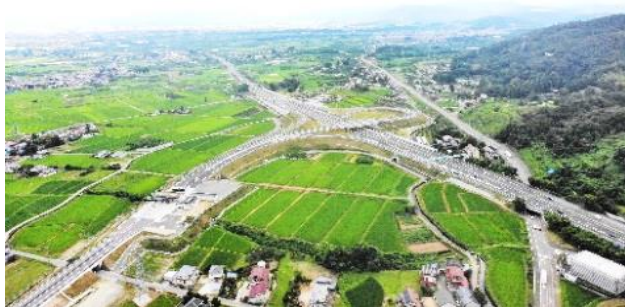
東北自動車道との結節点「桑折ジャンクション」
