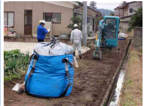
住宅の除染作業
