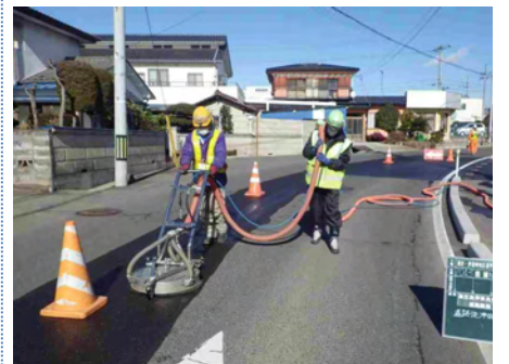
通学路の除染作業
