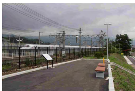
整備された桑折駅北広場
