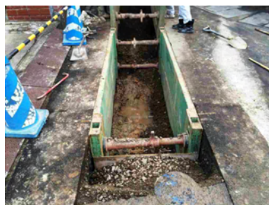
下水道工事の様子
