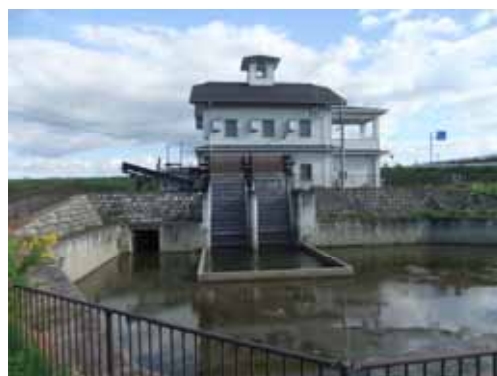
伊達崎排水機場
