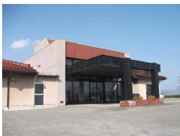
伊達市桑折町国見町火葬場
