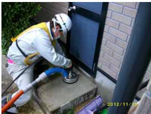
住宅除染作業の様子
