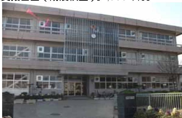
太陽光発電装置工事等を進める（醸芳小）
