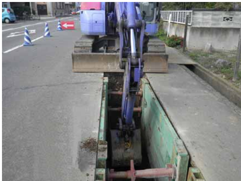
下水道工事の様子(谷地字道下地内)
