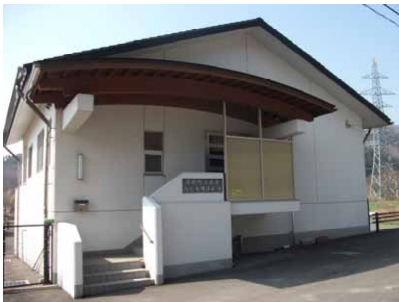
活性炭注入装置(放射性物質対策)を配備した内之馬場浄水場
