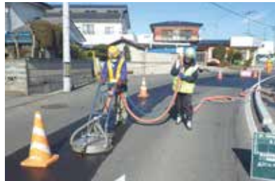
道路等の除染作業の様子
