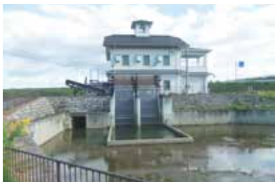
伊達崎排水機場
