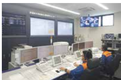
完成した伊達地方消防組合消防指令センター(H 28.4)
