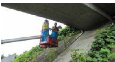
長寿命化に向けた橋梁点検
