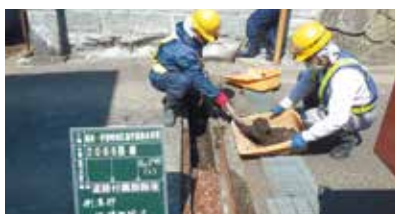
側溝堆積物撤去・処理作業の様子
