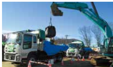
除去土壌等を仮置場から搬出
