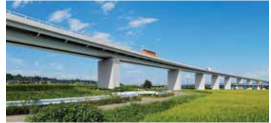
相馬福島道路「桑折高架橋」完成イメージ (成田字半五郎付近)
