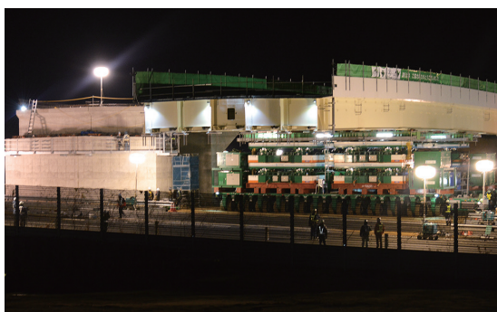
▶桑折JCTに高速道路の上を通るランプ橋が架かりました
