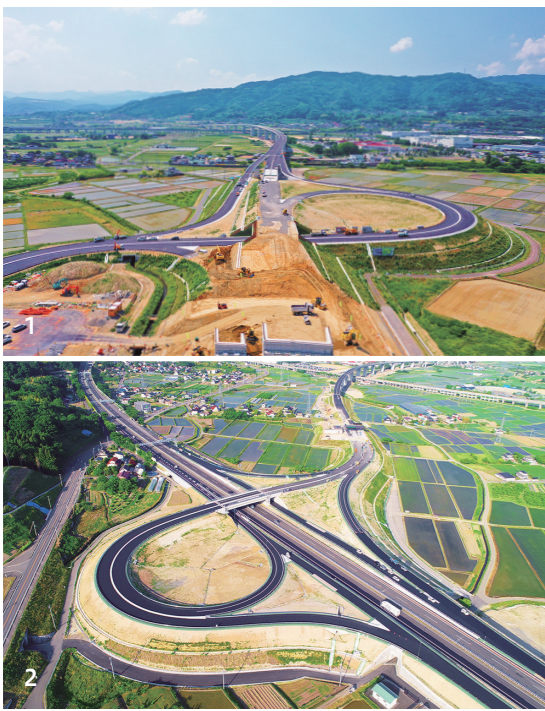
1 (仮称) 国道4号IC付近 2 完成間近の桑折JCT
