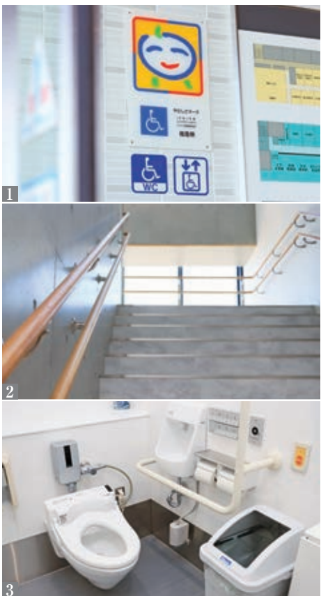
1_ やさしさマークを庁舎に掲示 2_2 重手すりをつけた階段 3_ 多機能トイレ
