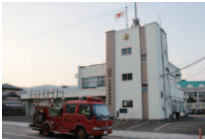
▲建替工事が始まる中央消防署西分署
