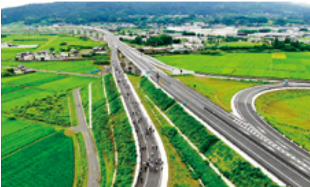
伊達桑折インターチェンジ周辺(令和2年7月)
