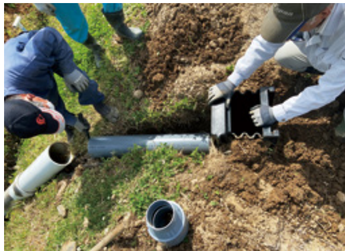
洪水被害軽減のための田んぼダム共同設置作業(令和3年5月)
