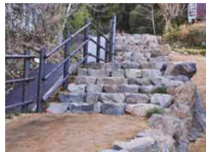
▲整備が完了した桑折西山城の入口
