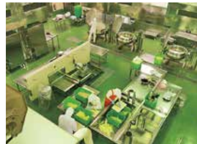
▲様々な設備機器が揃う調理室
