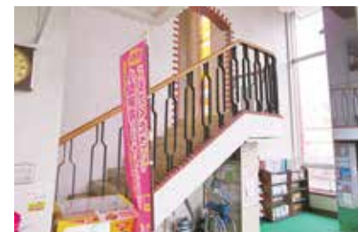
▲階段手すりを改修予定
