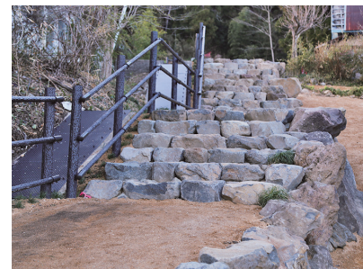
▲整備が完了した桑折西山城の入口
